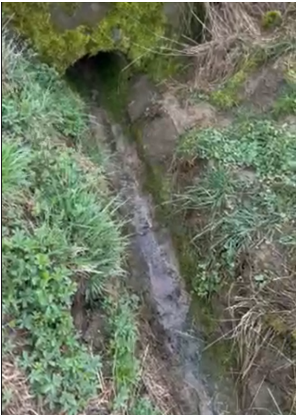
Abbildung 1: Beginn Rößgraben, Zulauf aus Drainagen (02.04.2024)
