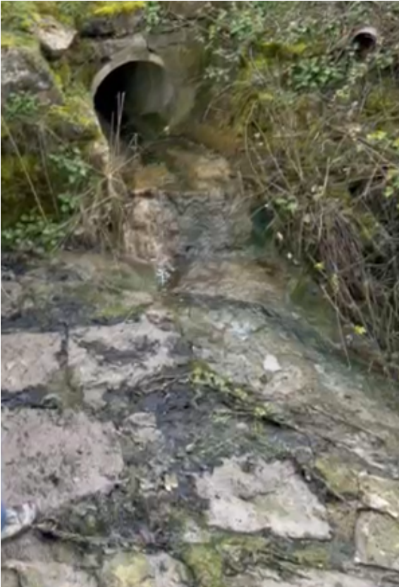
Abbildung 3: Rößegraben nach der Verdolung (02.04.2024)
