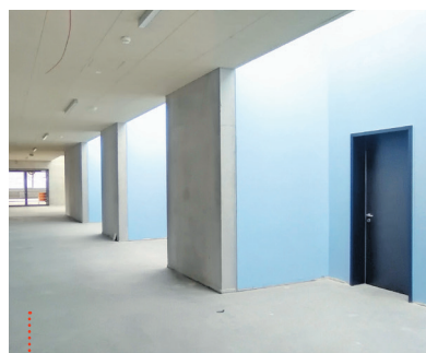
Tageslichtnutzung in den Fluren des neuen Werkstattbaus
