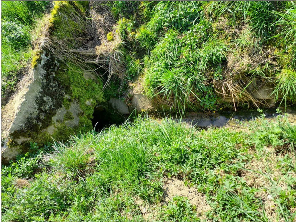
Abb. 3: Rohrdurchlass Rößgraben im Bereich der Ackerflächen (Ziffern 1-4)
