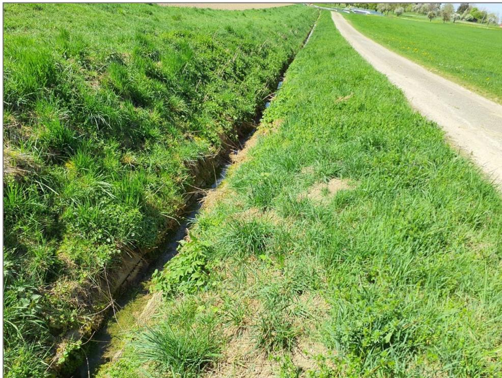
Abb. 2: Rößgraben im Bereich der Ackerflächen (Ziffer 1-4)
