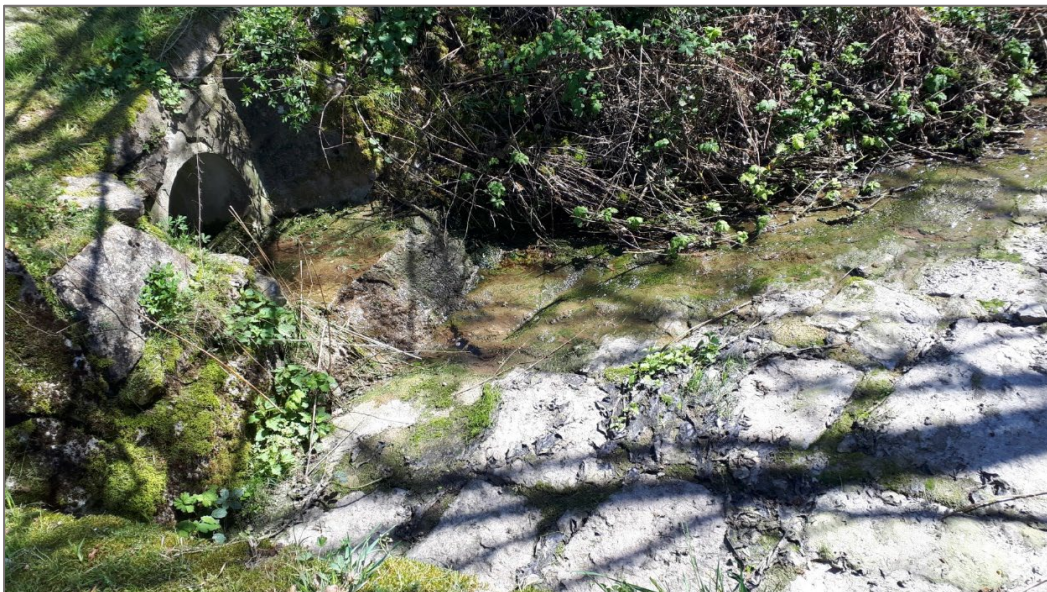
Abb. 4: Rößgraben aus der Verdolung nach der Rüblinger Siedlung (Ziffer 5)
