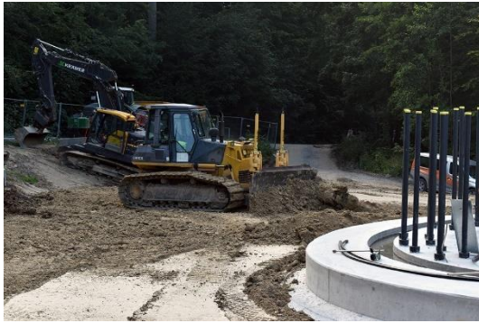
Abbildung 13: Das betonierte Fundament wird mit Erde angeeckt.
