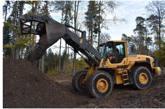
Abbildung 6: Abschieben des Oberbodens.
