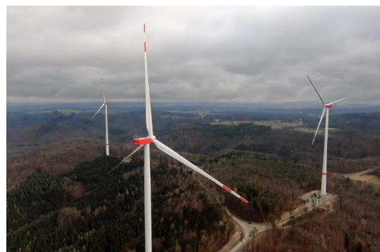
Abbildung 20: Nach weiterem Innenausbau der WEA kann diese in Betrieb gehen.
