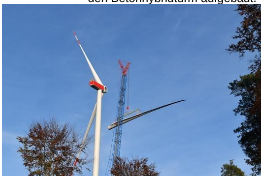
Abbildung 19: Mit einem Spezialhebewerk werden die Rotorblätter montiert.
