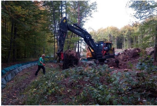
Abbildung 5: Nach Rodung der entsprechenden Flächen werden die Wurzelstöcke entfernt.
