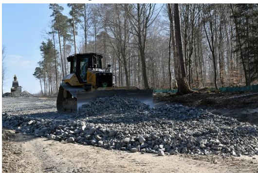
Abbildung 9: Für den Ausbau der Wege wird Schotter eingebracht.
