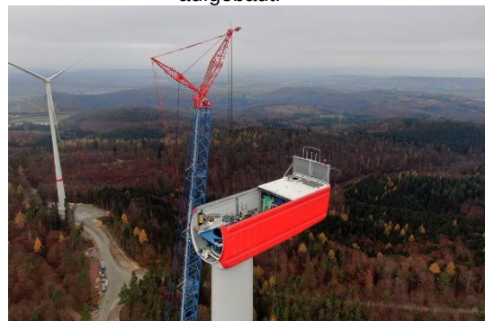
Abbildung 18: Mit Hilfe des Hauptkranes wird das Maschinenhaus angebracht.
