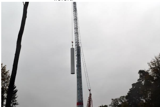
Abbildung 17: Mit dem Hauptkran werden die einzelnen Stahlurmsegmente auf den Betonhybridturm aufgebaut.
