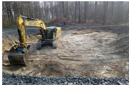
Abbildung 8: Weiter wird das Fundament der geplanten WEA ausgehoben.
