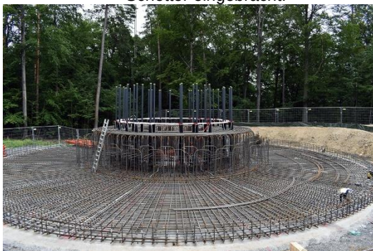
Abbildung 11: Mit Armierungsstahl wird die Grundlage für die Betonage geschaffen.
