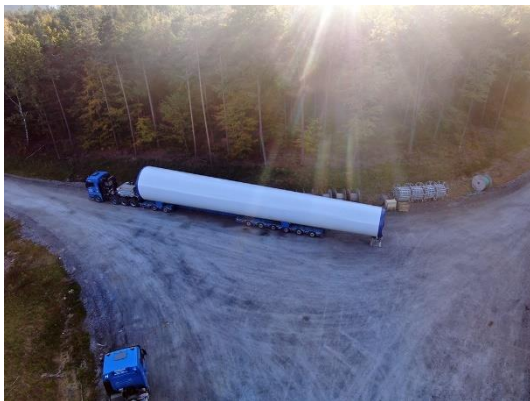
Abbildung 15: Mittels Schwerlasttransporte werden die Großkomponenten angeliefert.
