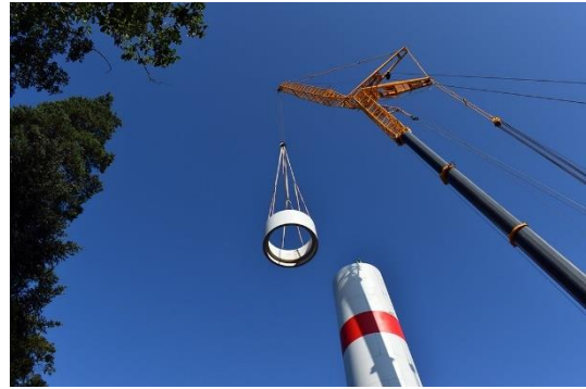
Abbildung 14: Vom Hauptkran werden die einzelnen Segmente des Betonhybridturms aufgebaut.
