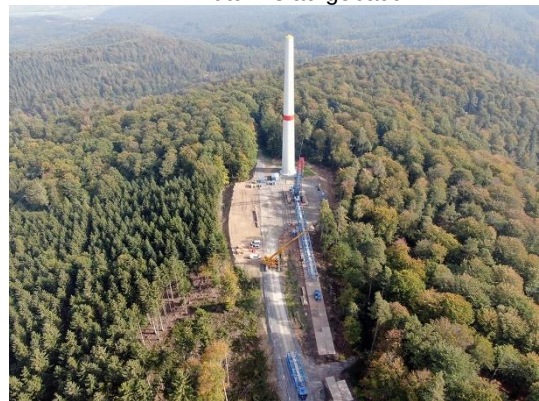
Abbildung 16: Für die Montage der Großkomponenten wird der Hauptkran aufgebaut.
