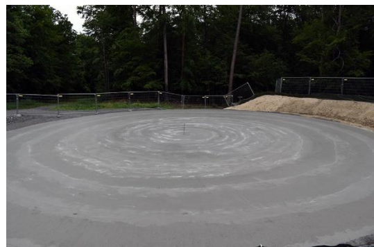
Abbildung 10: Für das Fundament wird eine Sauberkeitsschicht aufgetragen.
