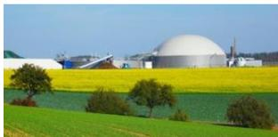
Die Anlage ist seit 2010 in Betrieb und wird mit organischen Materialien aus der Landwirtschaft betrieben. Durch die Vergärung wird Methangas erzeugt, das als Brennstoff im Blockheizkraftwerk genutzt werden kann. Der damit erzeugte Strom wird in das Stromnetz eingespeist und ist so Wärmeenergielieferant für Industriebetriebe und Wohnhäuser.
