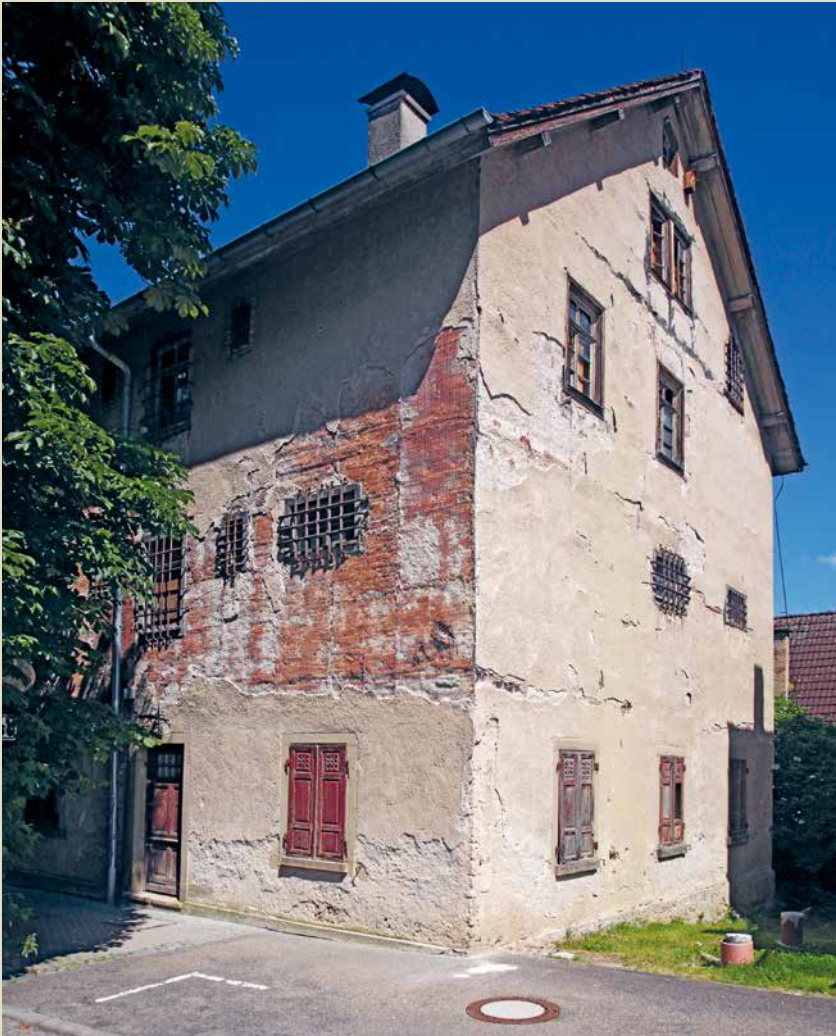
Ehemaliges Amtsgerichtsgefängnis in Künzelsau vor seiner Renovierung
