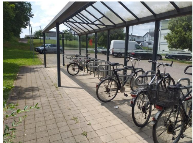
Abbildung 22: Anlehnbügel mit Vorderradhalterung (Bahnhof Bitzfeld)
