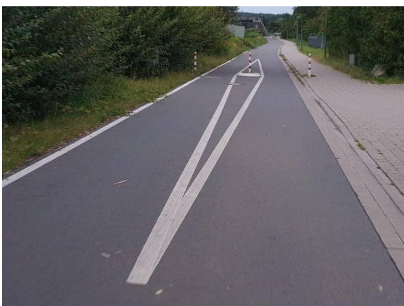
Abbildung 13: Sperrpfosten über Markierung gesichert (Osnabrück)
