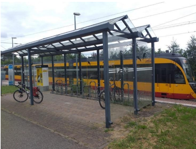
Abbildung 23: Überdachte Radabstellanlage, Gabelhalter (Bahnhof Cappel, S-Bahnhaltestelle)
