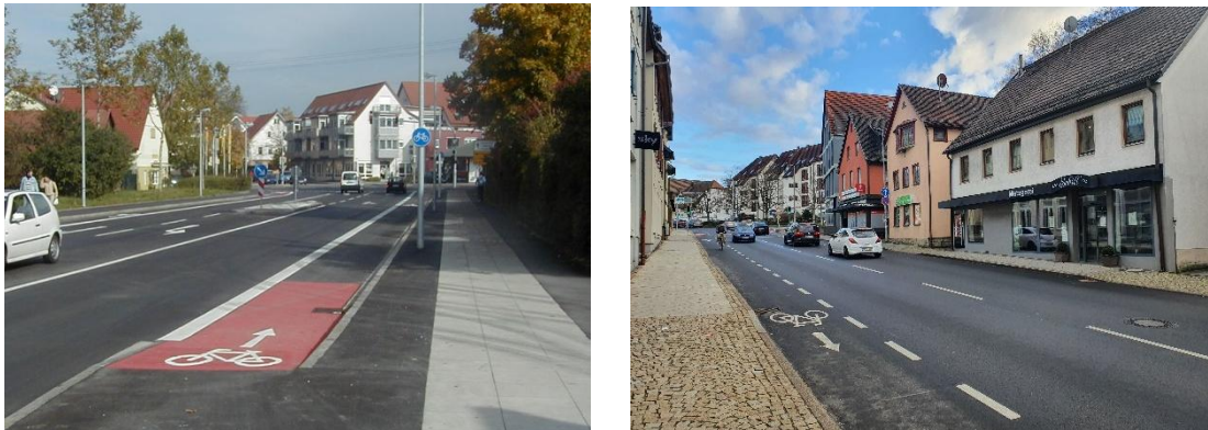
Abbildung 9: Radfahrstreifen Kirchheim u. T. (links), einseitiger Schutzstreifen Herrenberg (rechts)
