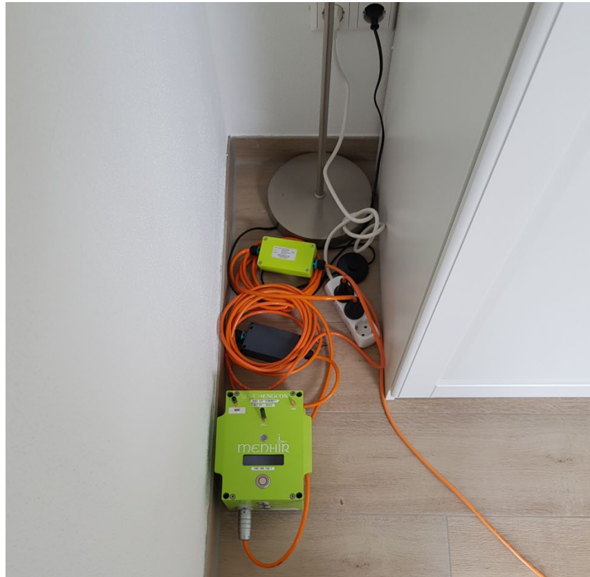
Detailaufnahme zum Messort OG aufsteigendes Mauerwerk IO 01 b
