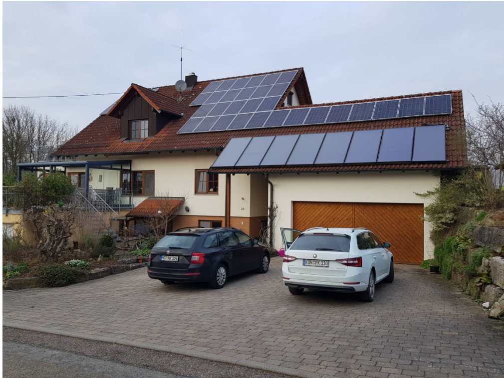
Außenansicht IO 03 - Whs Am Glockenturm 33, Blickrichtung Norden
