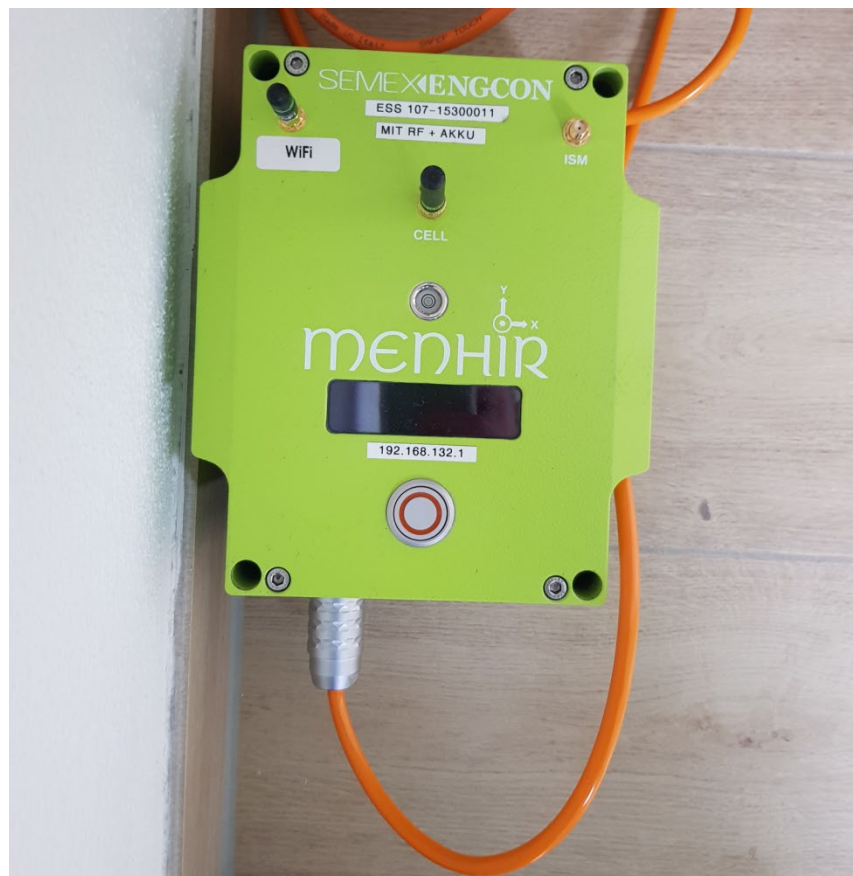
Detailaufnahme zum Messort OG aufsteigendes Mauerwerk IO 01 b
