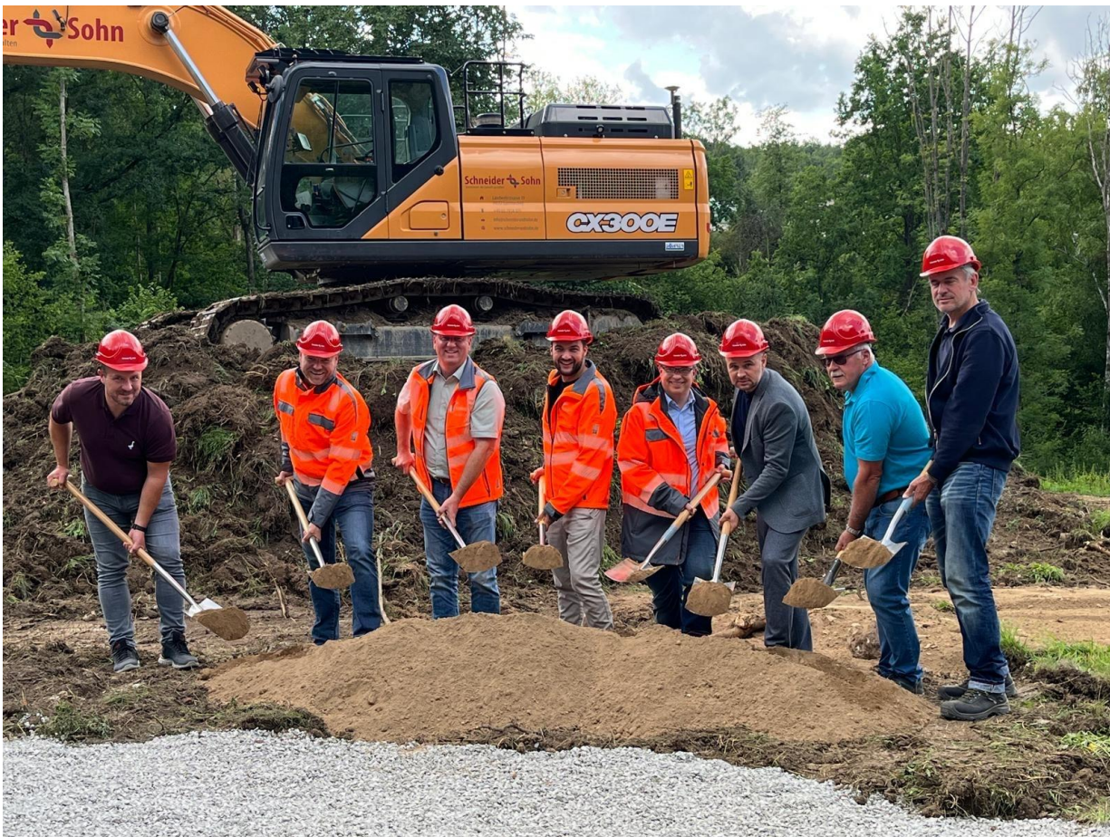
Bildunterschrift: Mit dem Spatenstich beginnt die Bauphase für den neuen Grüngutplatz Dörzbach-Hohebach.
